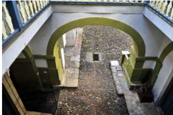
Figura 7 - Parte do piso feito da técnica pé de moleque
