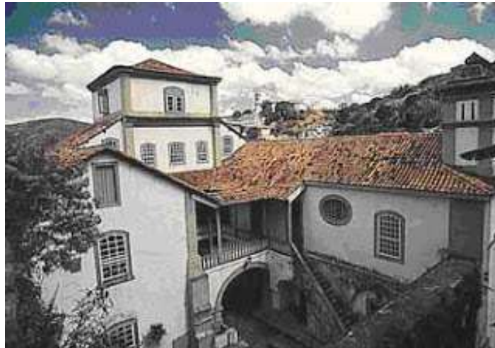
Figura 8 - Vista de parte da cobertura da Casa dos Contos
