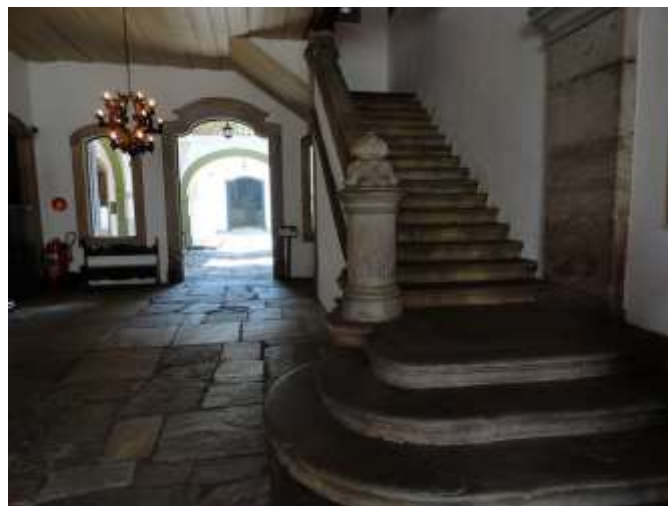
Figura 8 - Pisos lajeado da Casa dos Contos
