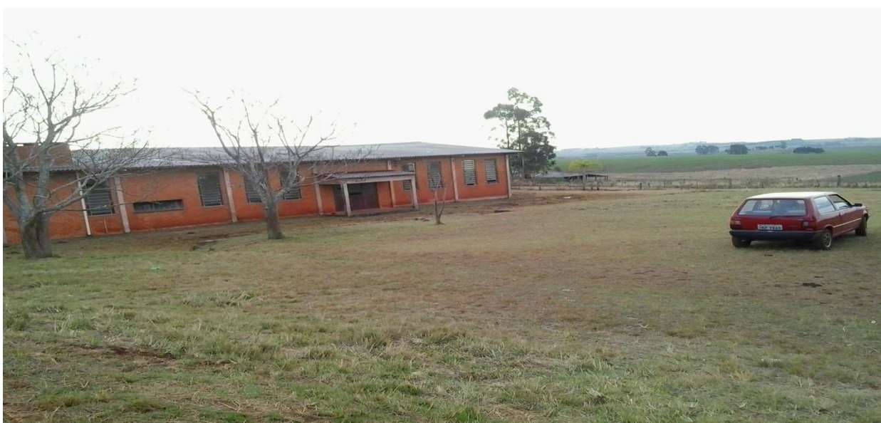
Figura 07 - Salão Comunitário do Reassentamento
