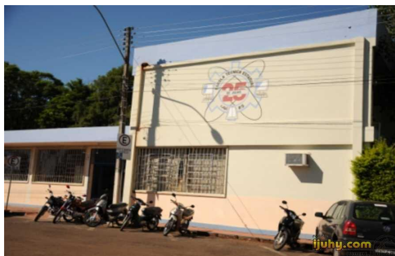
Figura 05: Escola Técnica Estadual 25 de Julho
