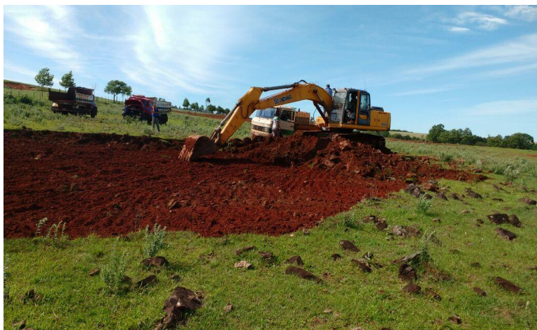
Figura 4. Preparando o terreno e separando materiais para recuperar erosão
