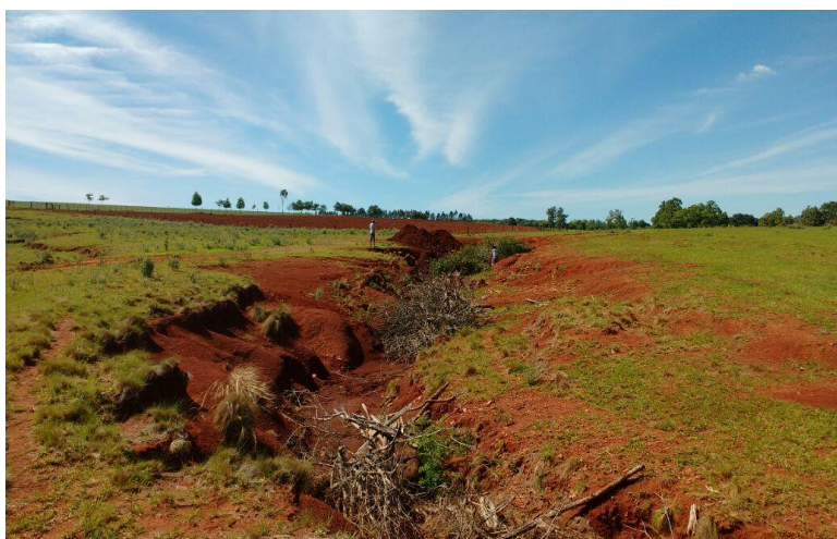
Figura 5. Recuperando as erosões (reposição de material na voçoroca)
