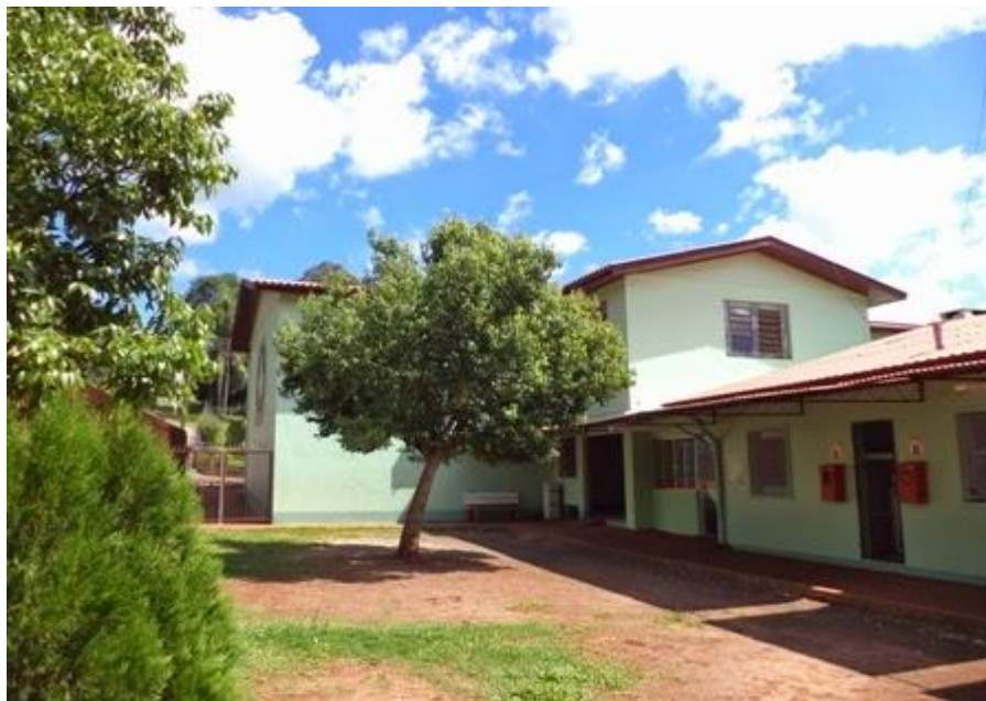
Figura 3: Ampliações. Fonte: Serviço de pessoal do Colégio.
